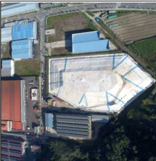
<시설 공사 시행전>
